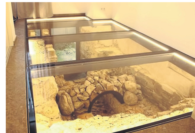
Die historisch bedeutende Warmluftheizung bleibt – unter Glas geschützt und beleuchtet – in Zukunft sichtbar.
